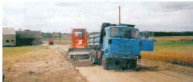
2000 - budowa drogi w Chromcu
