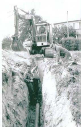
1991 - budowa wodociągu w Chwałęcino
