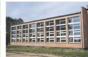
Nowowytbudowana sala gimnastyczna w Chociczy.
