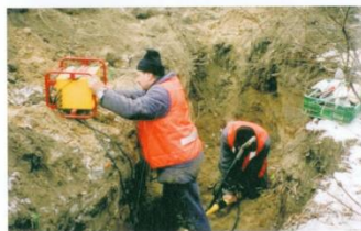
1995 - budowa gazociągu w Boguszynie
