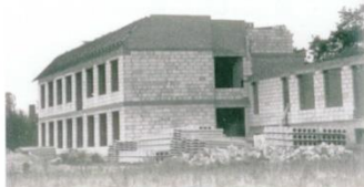
1991- 1993 Szkoła w Kłęce w trakcie budowy
