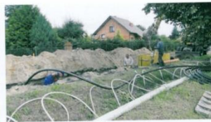
Budowa kanalizacji w Boguszynie
