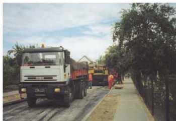
Budowa nawierzchni na ulicy Krzemińskiego w Chociczy
