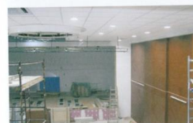
Prace modernizacyjne w GOK-u
