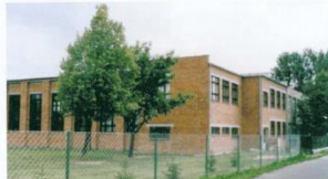
1996 - szkoła wraz z salą sportową po rozbudowie w Kolniczkach
