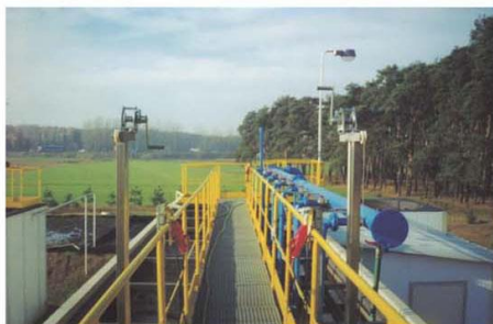
W Nowym Mieście rozbudowano oczyszczalnię ścieków
