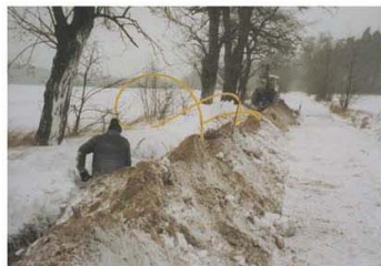
Budowa sieci gazowej w Boguszynie.
