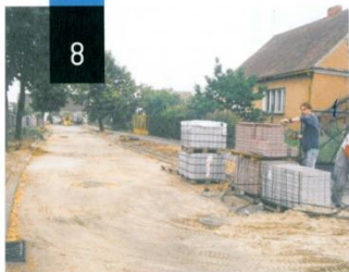
2000 - budowa ul. Krzymskiego w Chociczy
