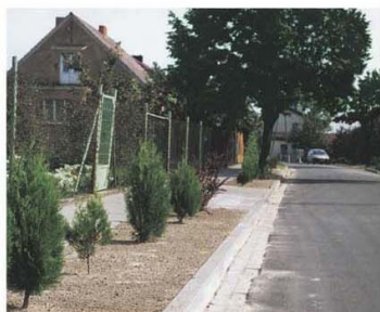
Nowa nawierzchnia na ulicy Krzemińskiego w Chociczy.
