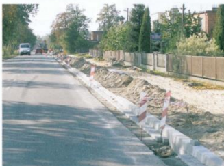
2004 - budowa chodnika w Boguszynie, ul. Śremska
